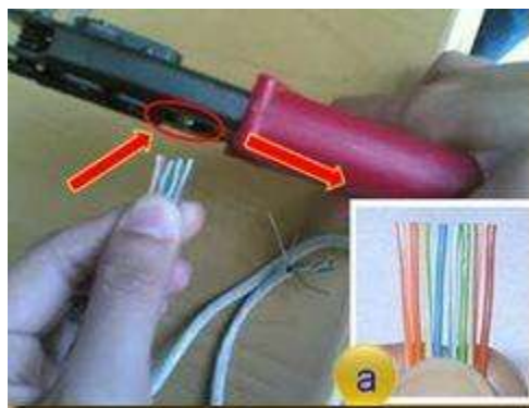
Gambar 3.23: Cara memotong ujung kabel
